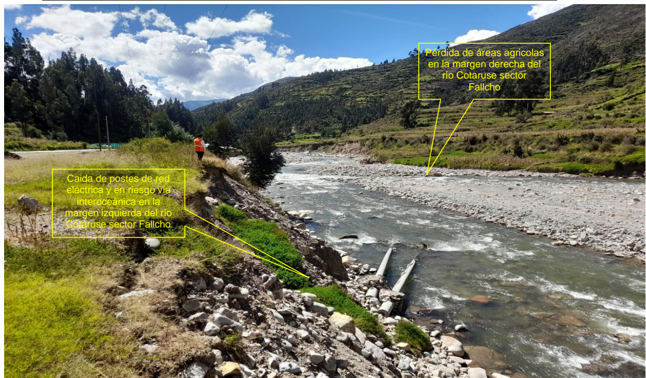
Imagen 2. Tramos críticos en el sector Falcho en ambas márgens del río Cotaruse, con erosión de talud y pérdida de áreas agrícolas con cultivo de maíz en la margen derecha y caída de postes en riesgo la vía interoceánica en la margen izquierda
